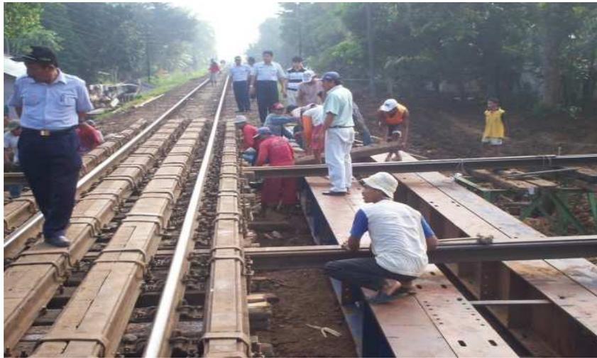
Gambar 3. Pemasangan rel bendel
