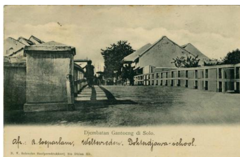
Gambar 7. Fasilitas Jembatan Gantung di Sungai Pepe
