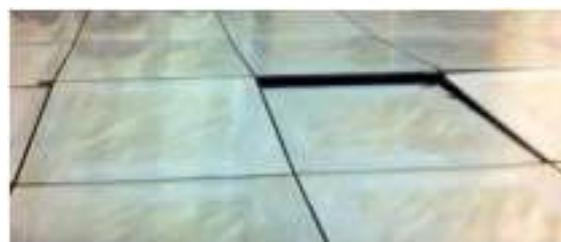
**Gambar 1. Beton menggelembung mengakibatkan keramik terangkat**
