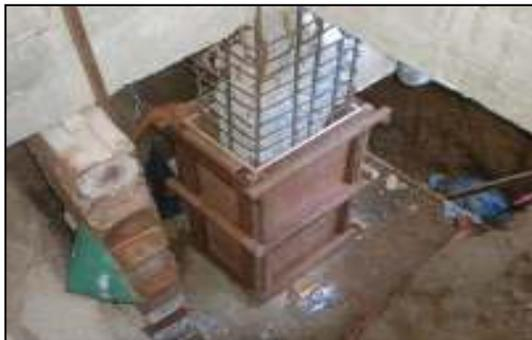
**Gambar 6. Proses Penyelubung Kolom**
