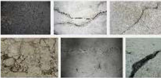
Gambar 3. Retak pada beton
