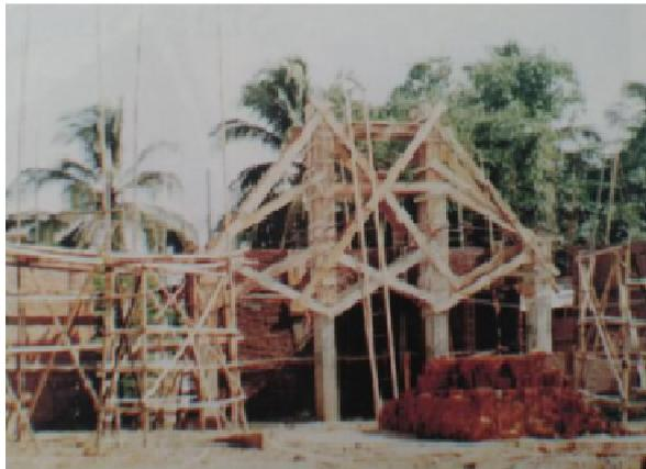
**Gambar 4.** Pengecoran kolom struktur dan pemasangan batu bata pada sisi samping kanan gereja
