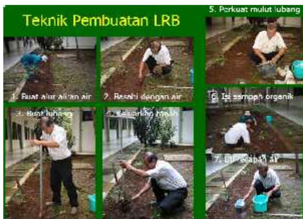
**Gambar 1. Teknik Pembuatan Lubang Resapan Biopori**
